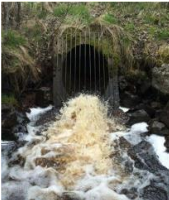
Figur 5. Kulvert under E20 med avlett vatten norr om motorvägen.
