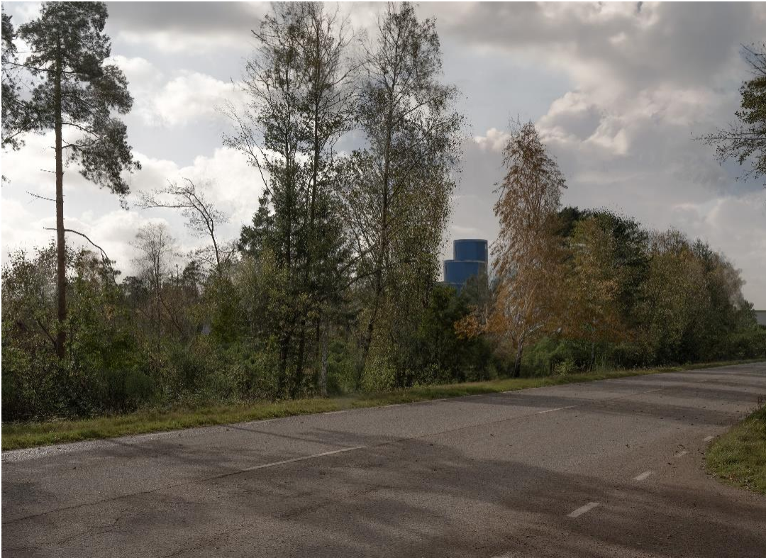
Figur 10-19 Foto mot sydväst från väg 1838. Asfaltverket sticker upp bakom vegetationsridån.
